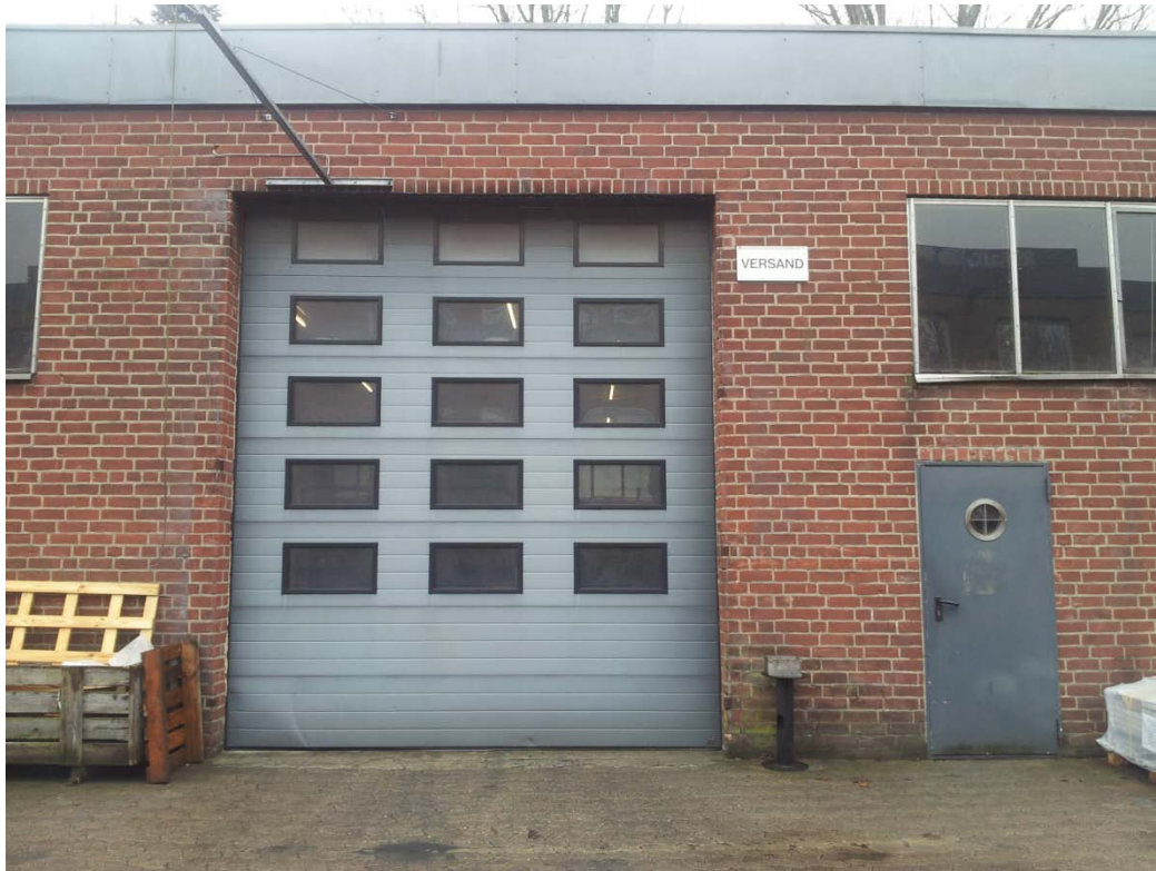
Versandbereich von außen mit geschlossenem Rolltor
