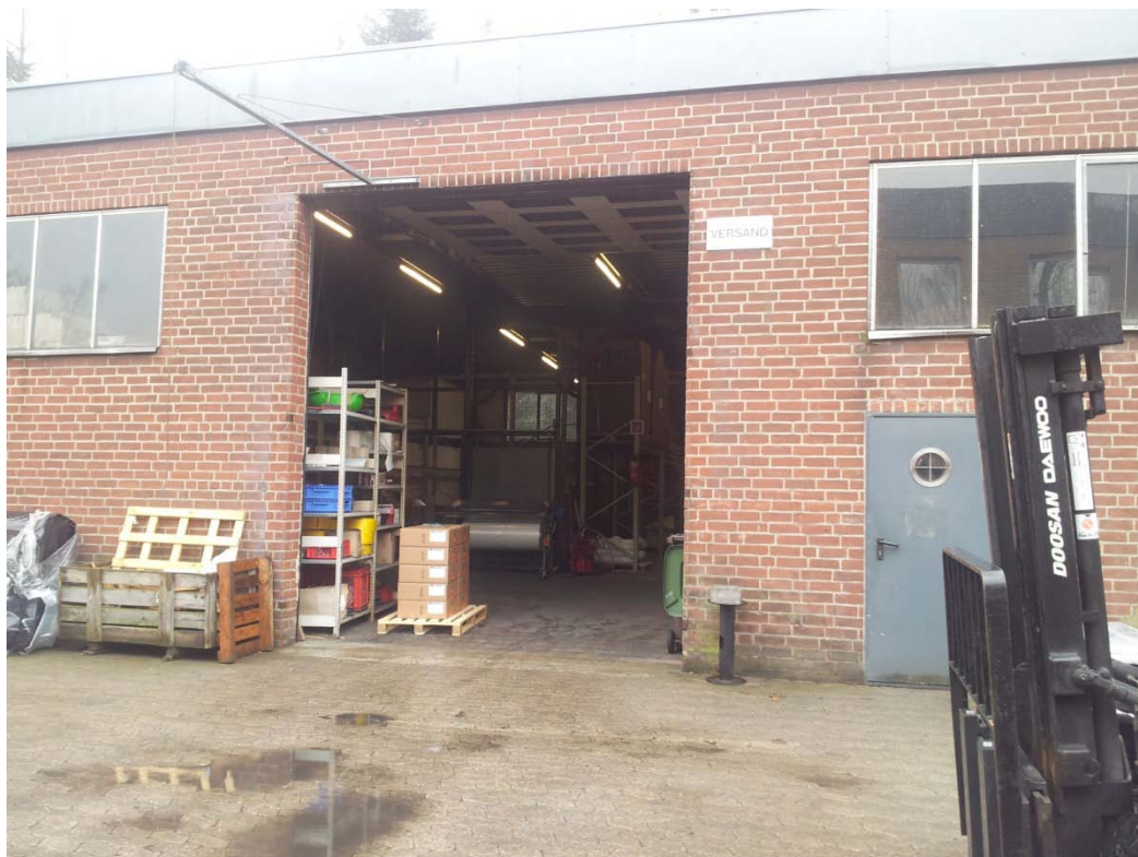
Versandbereich von außen mit geöffnetem Rolltor
