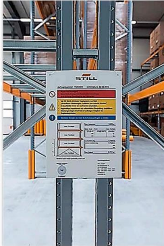
„Anlagenschild“ (Typenschild)
